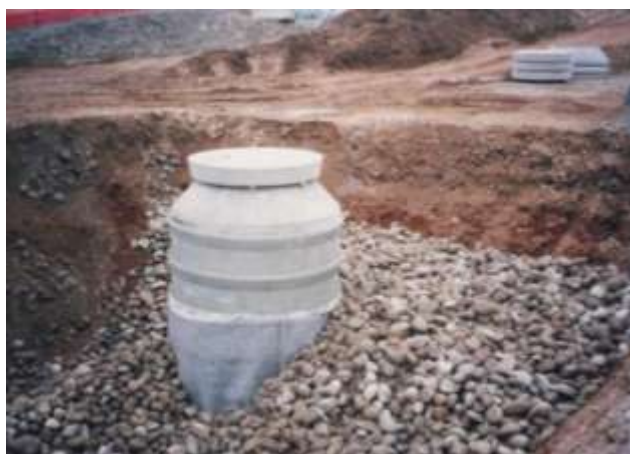
Esempio tipologico di pozzetto disperdente.
