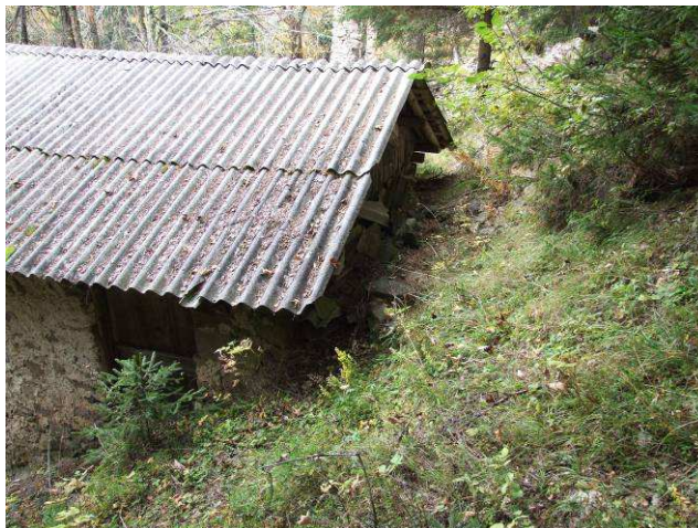
PARTICOLARE: EST e NORD
