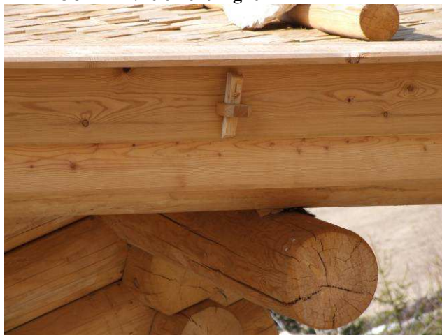
PARTICOLARE: elementi lignei
