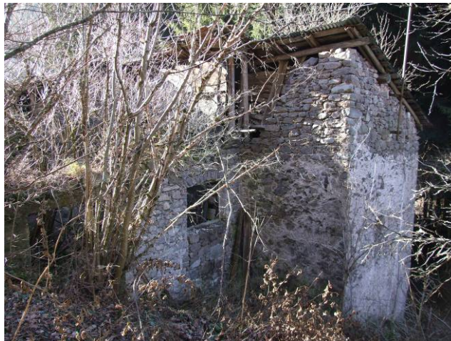
PARTICOLARE: EST e NORD
